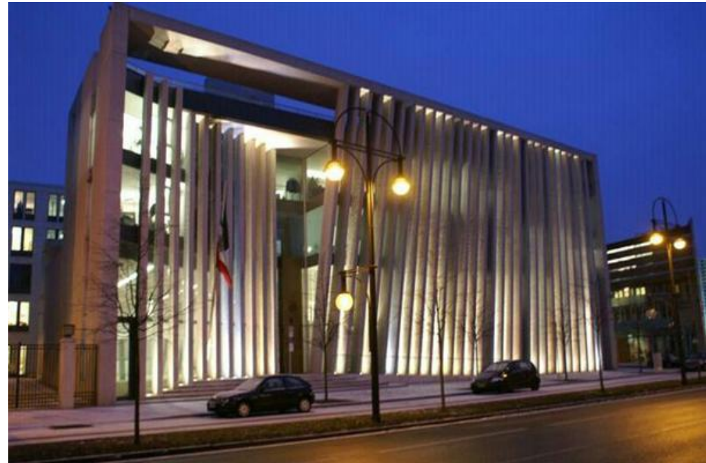
Embajada de México en Berlín. Teodoro González de León y Francisco Serrano Cacho
